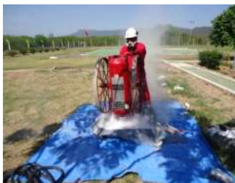
Mantenimiento de Extintores Portátiles y Rodantes. Vaciado y tamizado de PQS.
