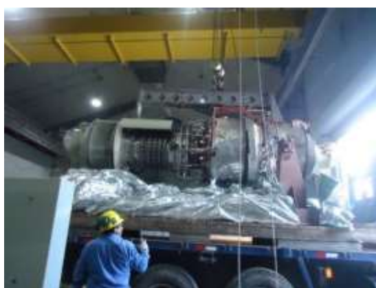
Supervisión en trabajos de izaje, apoyo en traslado y trabajos cambio de turbina en estación Roboré y Chiquitos.
