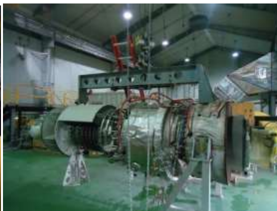
Supervisión en trabajos de izaje, apoyo en traslado y trabajos cambio de turbina en estación Yacuses, Roboré y Chiquitos.
