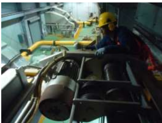
Inspección, verificación y mantenimiento de partes de tecles y puentes, prueba de tinta penetrante a ganchos
