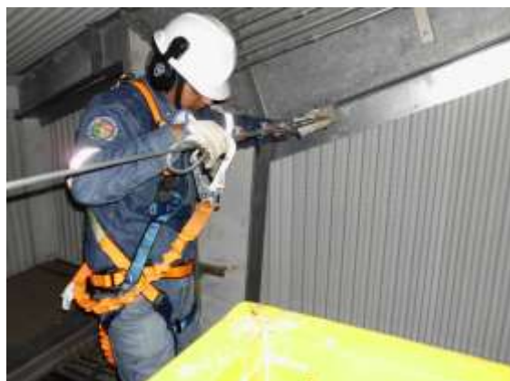
Tensionado de Líneas de Vida y prueba de carga
