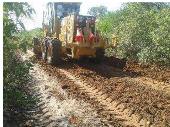
Supervisión en mantenimiento y perfilado del DDV KP-241 al KP-190
