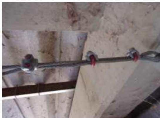
Verificación de Grapas, Tesadores, guardacabos, grilletes y puntos de anclaje
