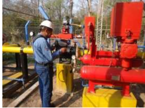
Medición de fugas de gas en los corralitos de válvulas y termo generadores.
