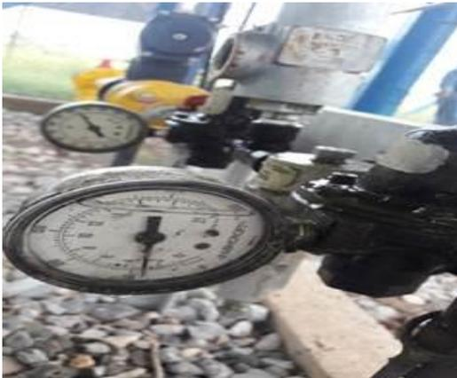
2. Para el ítem 4 indicar la presión de set ya que solo indica la presión máxima de trabajo.
